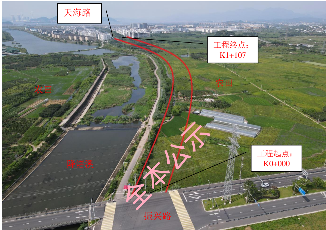
图 2.7-3 工程现场照片
